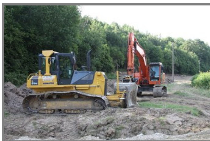
Construction du bassin de retenue d'eau d'une capacité de 7000 m 3 à Aizier (Ouvrage III.9)
